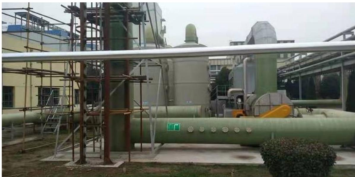
图 6-10 碱洗+水喷淋+UV 光解+活性炭吸附装置
