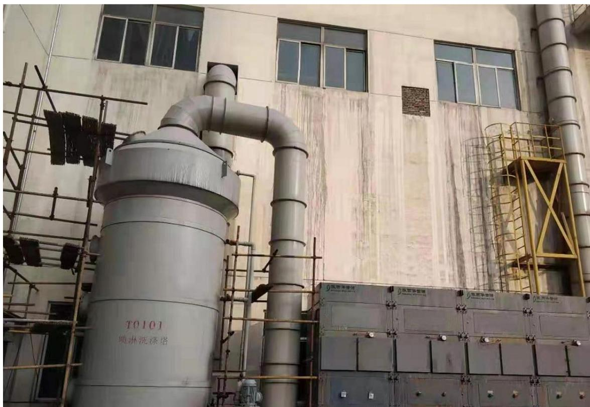
图 6-8 喷淋洗涤+活性炭吸附浓缩+催化燃烧+UV 光解活性炭净化
