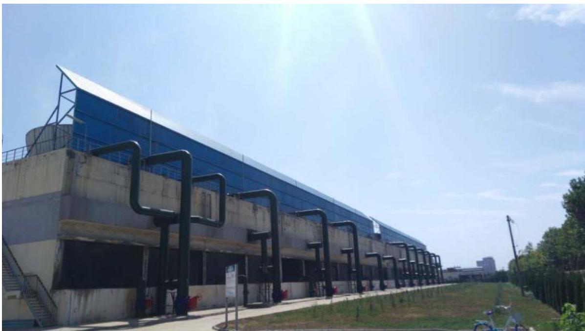
图 6-22 三期冷水塔上部加装隔音降噪装置图
