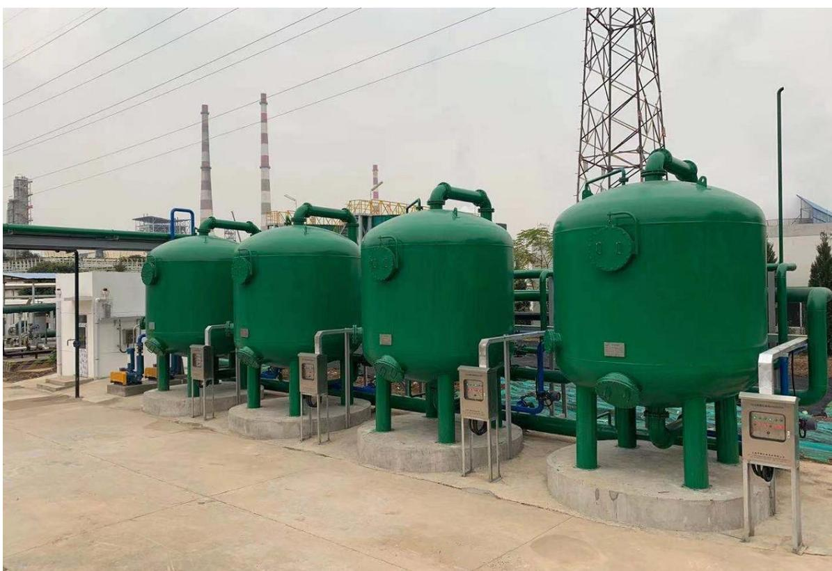
图 6-12 460B 深度回用项目过滤器
