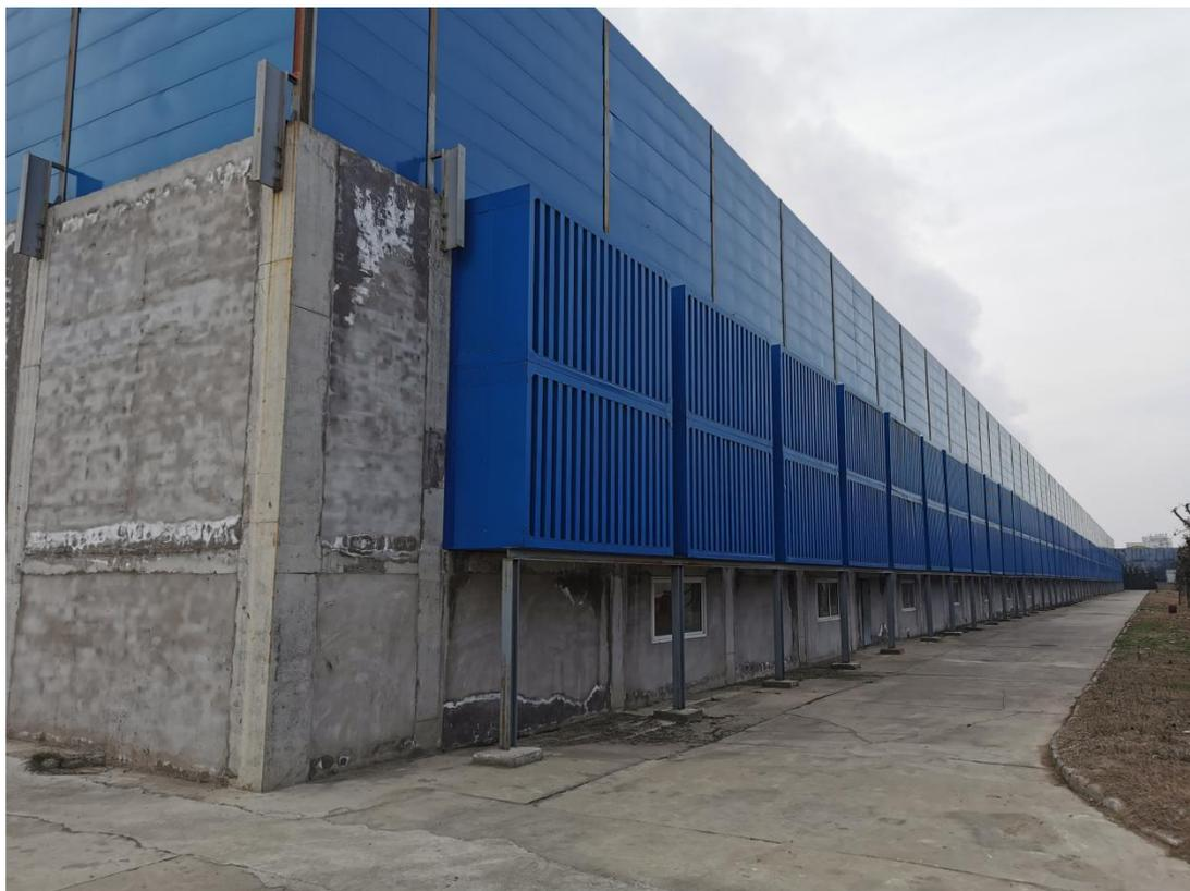
图 6-23 三期循环水隔音降噪装置图
