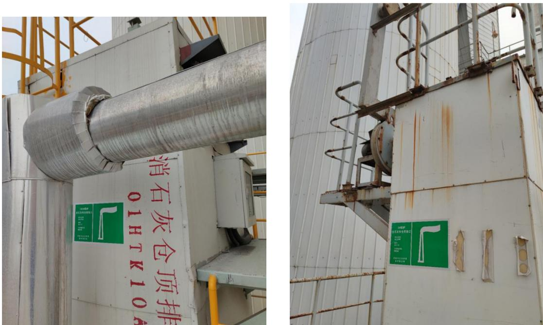
图 6-4 布袋除尘器排放口（因厂区布袋除尘器较多，随机拍摄）
